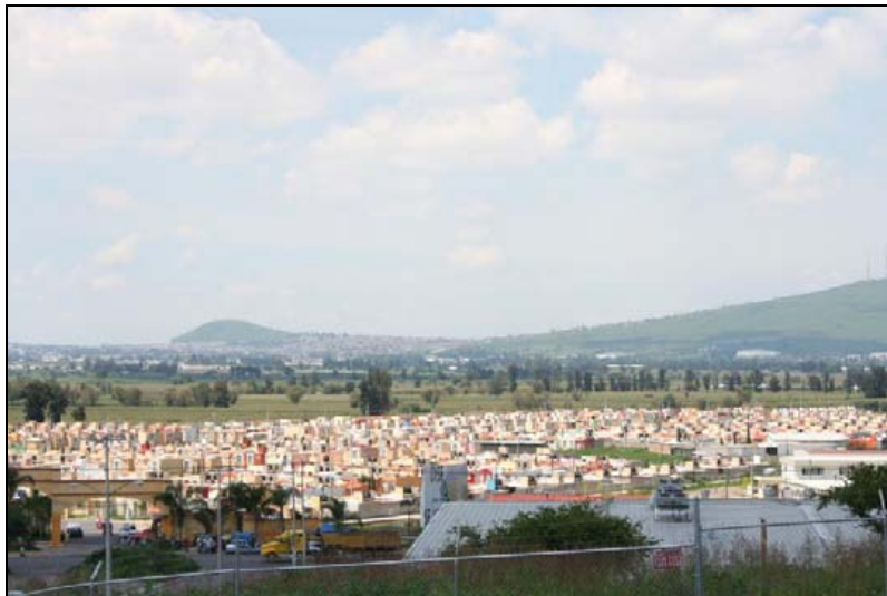
Foto 4.1. Crecimiento urbano sobre el valle agrícola de Tlajomulco mediante manchas aisladas que complican el flujo del agua.
