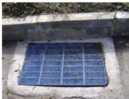
Figura 18. Protección de alcantarillado.
