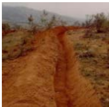
Figura 17. Desvío temporal de cauce.
