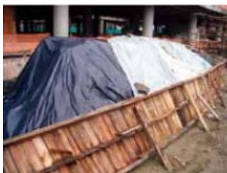
Figura 4. Control de escorrentías y erosión del suelo.
