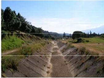
Figura 18. Canal colector de aguas pluviales dentro del parque ecológico “Las Peñas”
