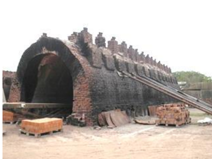
Horno tipo túnel
