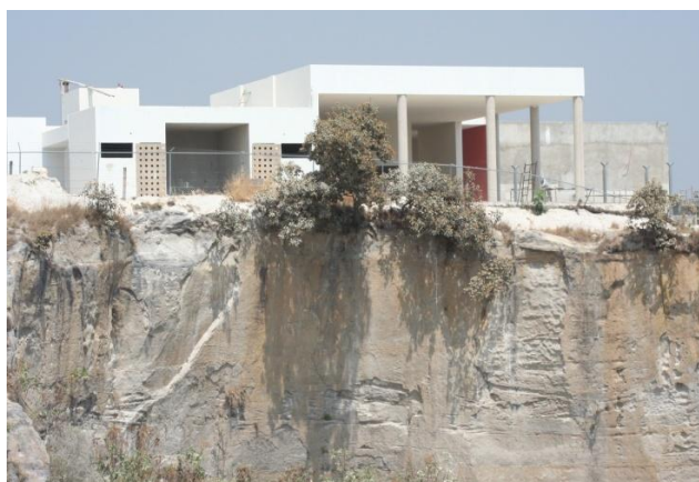
Figura No. 39. Urbanización cerca de un escarpe inestable por las condiciones de pendiente y el tipo de material que lo forman.
