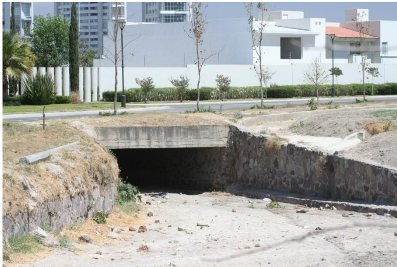
Figura No. 46. Sección hidráulica que produce el confinamiento del canal a la mitad de sus dimensiones.
