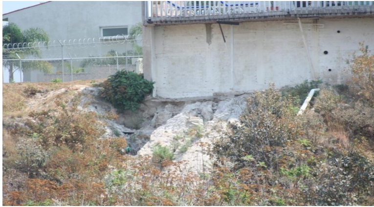
Figura No. 41. Asentamiento de viviendas debido a procesos de erosión acelerada, no considerados en el proyecto de construcción, con el consecuente riesgo de colapso de la estructura.
