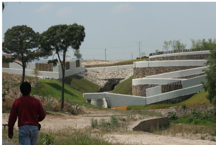
Figura No. 34. Obras que afectan la funcionalidad de los cauces ya que alteran el perfil.
