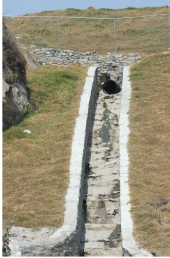
Figura No. 33. Substitución de un canal de jerarquía uno por uno antropizado. Se puede observa una pendiente constante así como una concentración del flujo aunque se trata de romper la velocidad del agua, está incrementa la velocidad y la taza de erosión y está modificando los proceso erosivos a nivel de canal principal.
