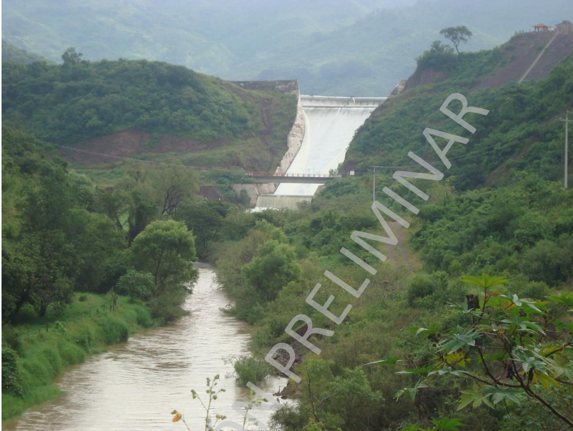
Imagen 31. Vertedero de la presa El Carrizo en Tamazula, Jalisco (Fuente propia)
