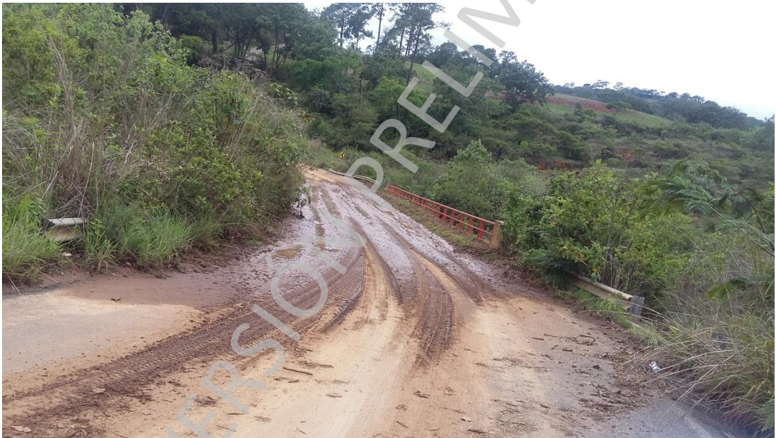
Imagen 59. Depósitos de suelo erosionado en una sola tormenta, proveniente de terrenos con surcado a favor de la pendiente, en el municipio de Tamazula. (Fuente propia)
